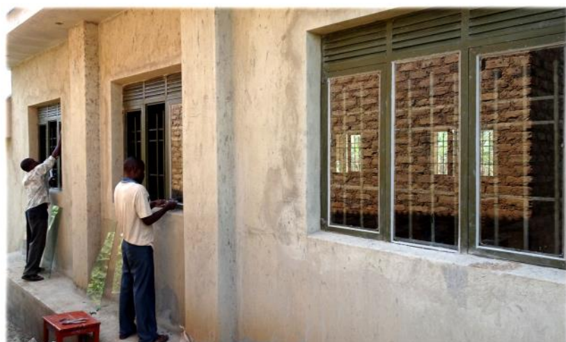
Oben: Die Fensterscheiben werden eingesetzt.
